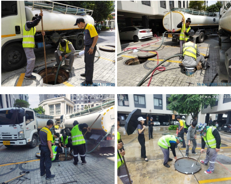
ภาพที่ 3-31 ซ่อมบำรุงระบบบำบัดน้ำเสีย สูบตะกอนไขมันและสูบตะกอนบ่อเกรอะ และระหว่างดำเนินการใช้กรวยกัน และดำเนินการในช่วงเวลากลางวัน
