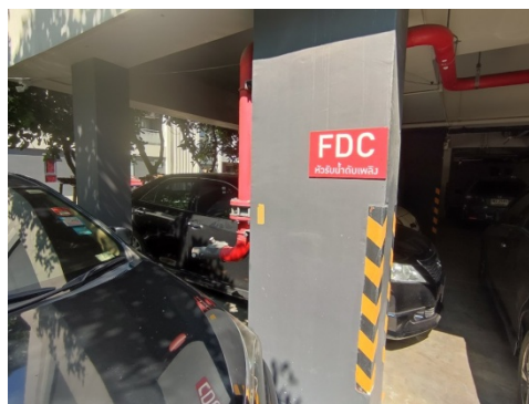
ภาพที่ 3-26 หักรับน้ำดับเพลิงจากภายนอก
