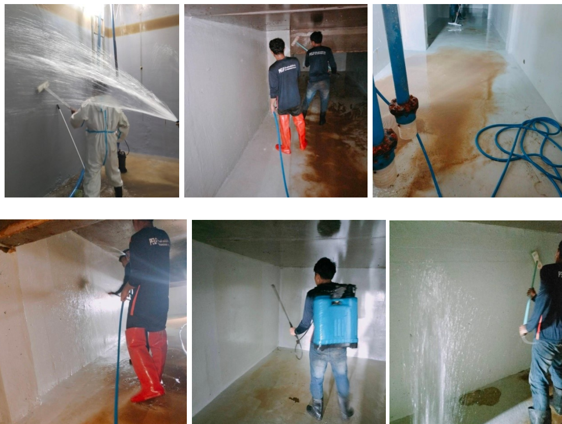
ภาพที่ 3-28 ล้างทำความสะอาดบ่อสำรองน้ำใช้
